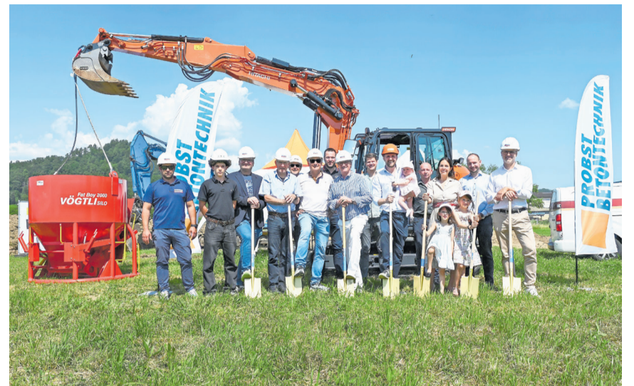
An der Industriestrasse 12 erfolgte der Spatenstich zum neuen Firmensitz.
